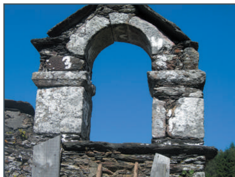
Espadana, ben fotografada e numerada, antes das obras
