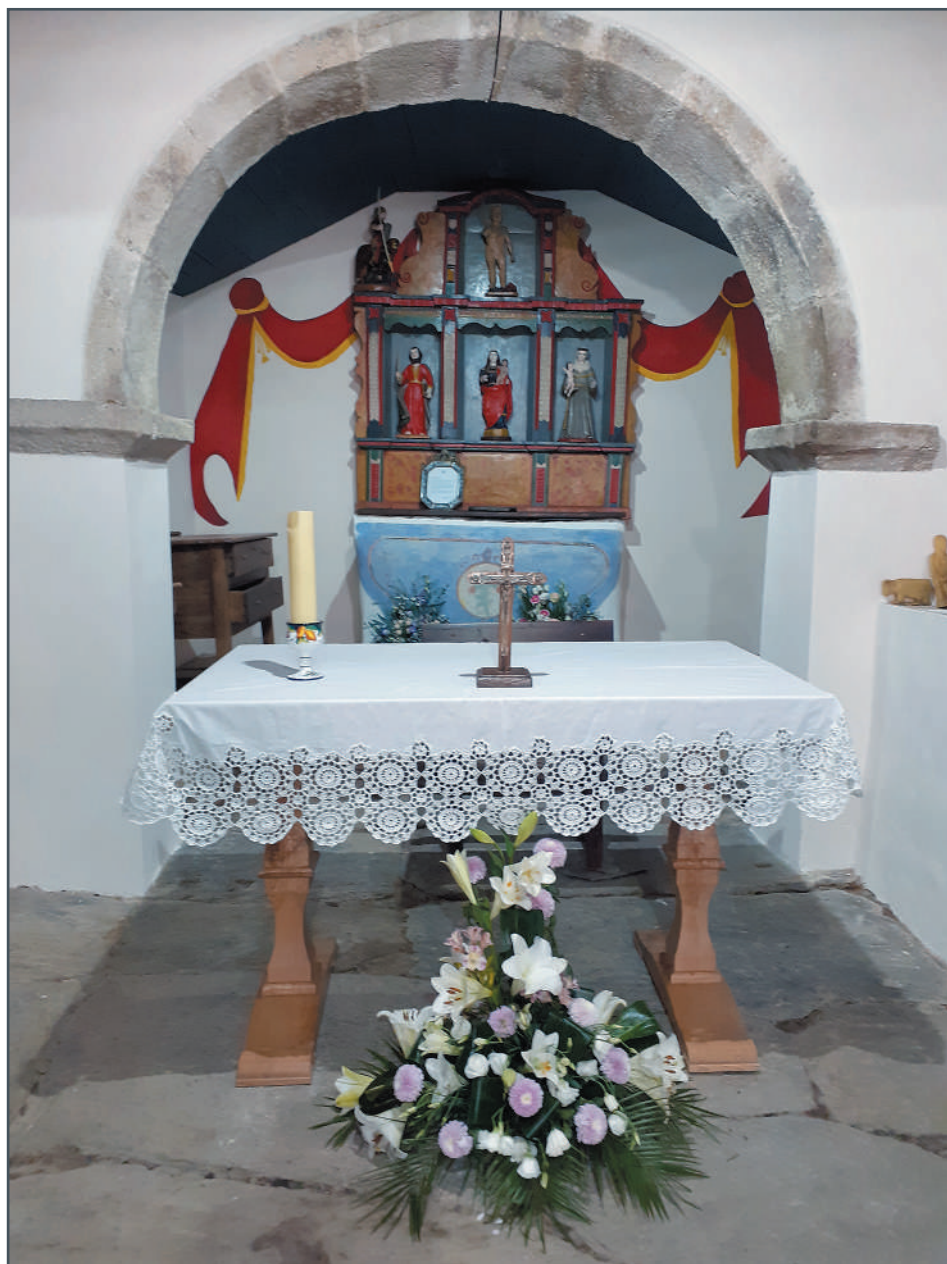
Resultado final da visión do arco despois do recebo con morteiro de cal e pintado
