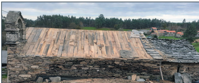
Nesta fotografía obsérvase a estrutura elevada sobre o nivel do tellado para asentar a espadana
