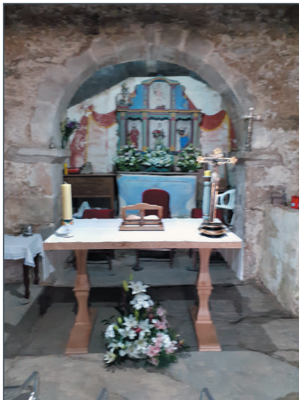
Imaxe do arco antes de rematar co recebo de morteiro de cal
