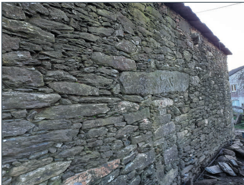
Vese o lintel e o pedrexado de tapiar unha porta lateral pequena
