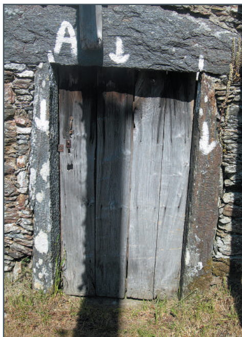
Porta principal, ben datada, fotografada e numerada antes das obras para proceder á desmontaxe da fachada
