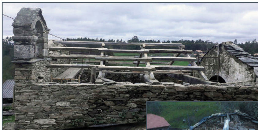
Vista lateral de como ía a estrutura de madeira
