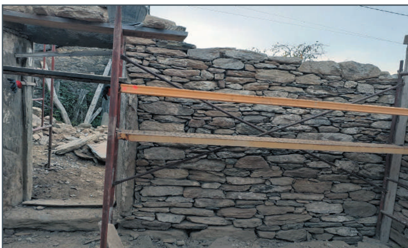
A parede da fachada comezaba a recobrar vida, erguida coa pedra que fora desmontada e seleccionada con anterioridade
