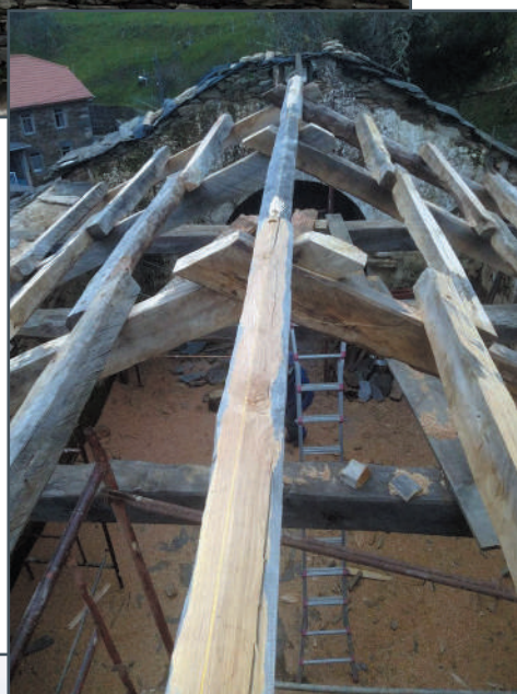
Estrutura de madeira rematada
