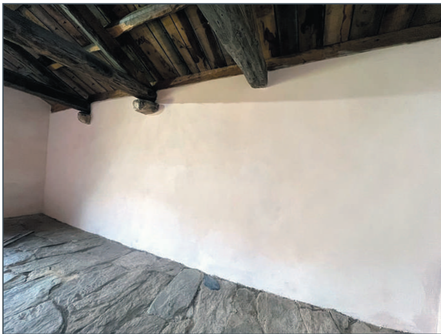
Parede lateral lista despois de pintada
