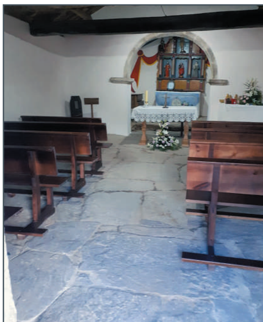
Interior unha vez rematada a rehabilitación. Pódese ver o chan de chantas de lousa da ermida orixinal
