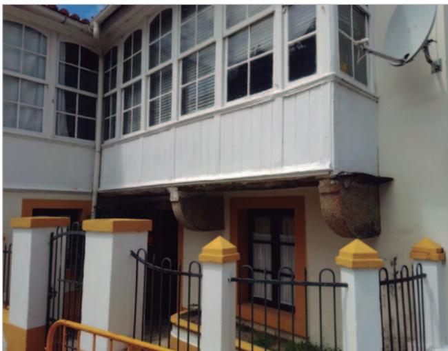
Fig. 27: galería con soportes de granito e piso de lousa, en Ares. Probablemente, esta estrutura fora anteriormente un corredor
