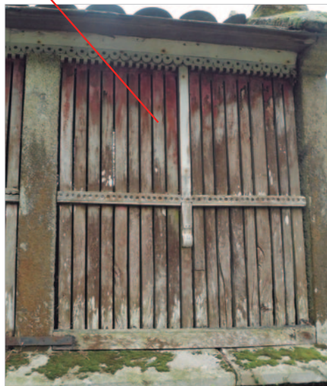
Figura 13: Armazóns verticais de ventilación. O Canedo, Santa Xiá (MO_HR_08). Fonte propia
