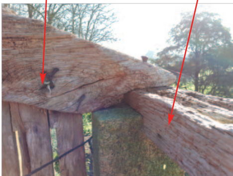
Figura 20: Detalle da trabe curva, soleira, columnas e doelas. Casal do Salgueiro, San Fiz. Fonte propia
