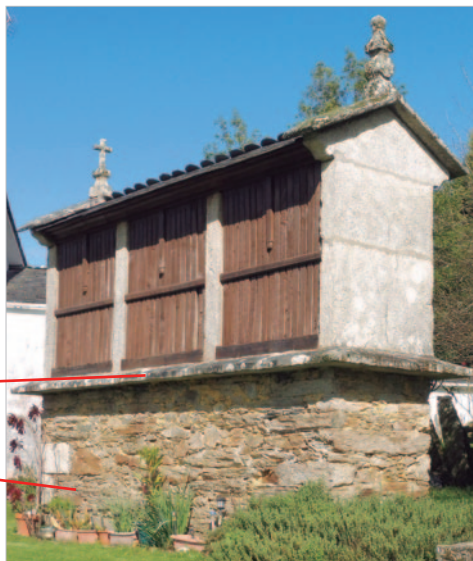
Figura 9: Cepa de cachotería de xisto e tornarratos formado por lousa de granito. Río Seco, Santa Xíá (MO_HR_09). Fonte propia
