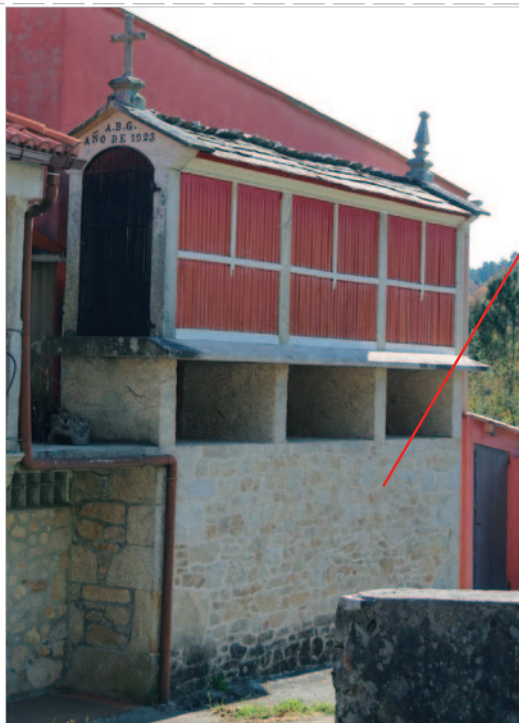
Figura 5: Hórreo mixto con muretes transversais. Vilaboi, San Fiz (MO_HR_05). Fonte propia
