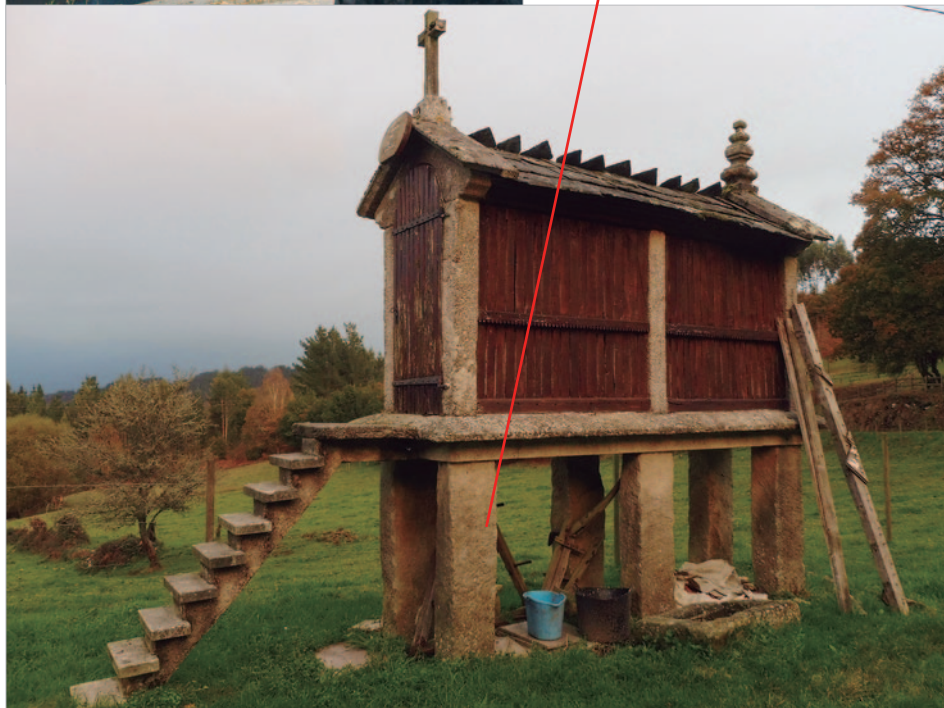
Figura 6: Hórreo mixto con esteos de granito. Eirabella, San Fiz (MO_HR_07). Fonte propia
