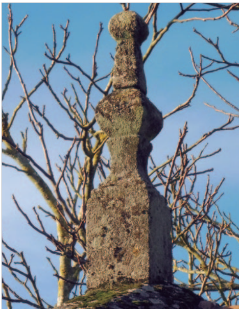
Figura 22: Lampión de granito en hórreo. Feal, Vilachá (MO_HR_03). Fonte propia
