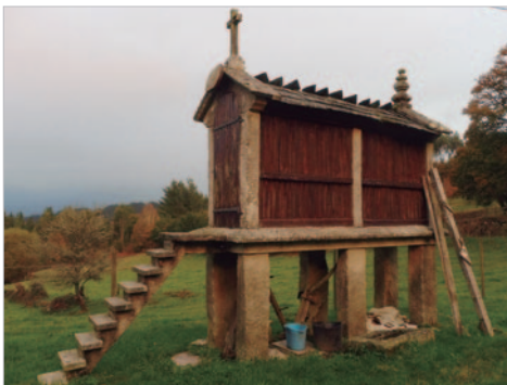
Figura 15: Escalera de trabe zanca de formigón. Eirabella, San Fiz (MO_HR_07). Fonte propia
