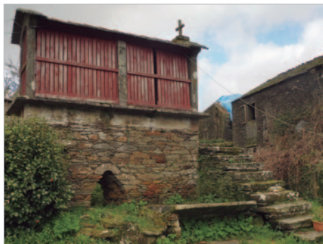
Figura 14: Escalera fija de estrutura de cachotería de xisto e chanzos de lousas de xisto. Caulfe, Alto Xestoso (MO_HR_14). Fonte propia
