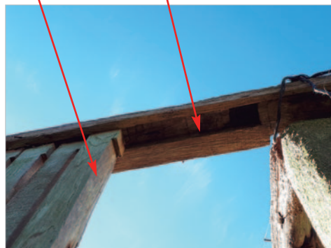
Figura 19: Detalle do encaixe das doelas verticais na soleira. Casal do Salgueiro, San Fiz. Fonte propia
