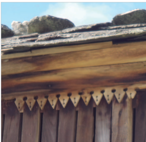
Figura 24: Ornamentación de madeira en forma de frechas no beirado do hórreo. Abercovo, Vilachá (MO_HR_04). Fonte propia
