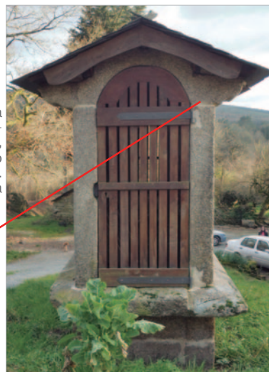
Figura 11: Porta de doelas verticais. Portolago, Alto Xestoso (MO_HR_13). Fonte propia
