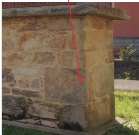
Figura 23: "Gualdrapeados" de granito na cepa do hórreo. Ponte da Pedra, Queixeiro (MO_HR_01). Fonte propia
