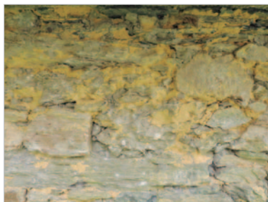
Figura 8: Detalle da cachotería de xisto na cepa do hórreo. Río seco, Santa Xíá (MO_HR_09). Fonte propia
