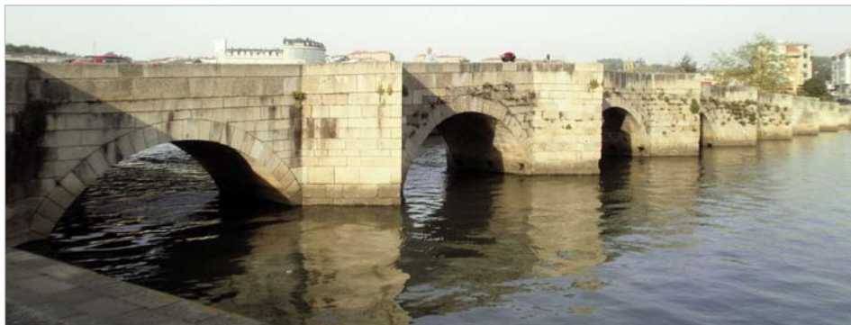
Ponte do Burgo
