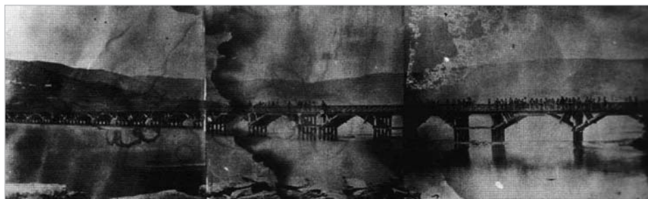
Ponte provisional de madeira
