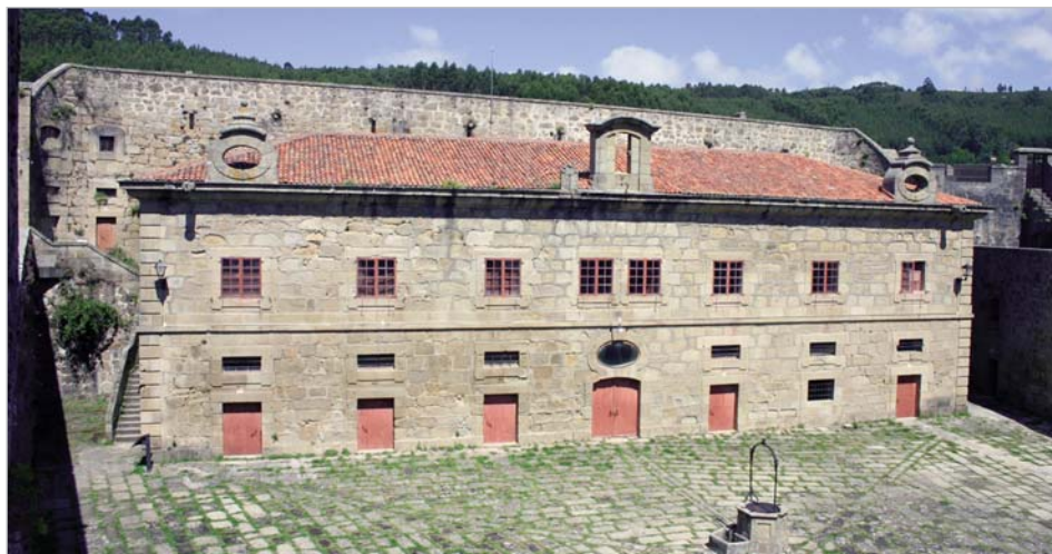
Casa do Gobernador. Reloxo solar na cornixa da cuberta ao lado da espadaña pétrea central
