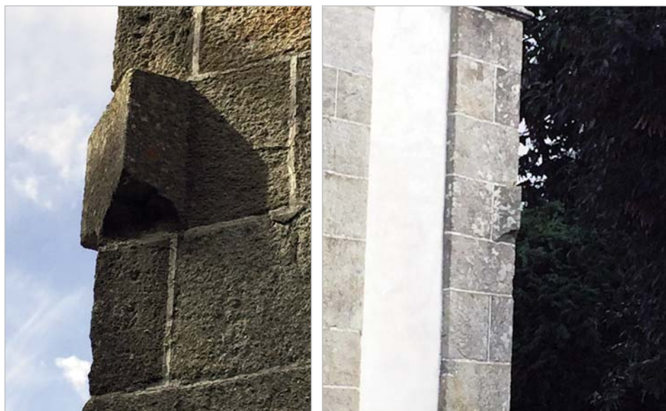
Detalles do fronte e vistas laterais do sillar labrado para reloxo solar
