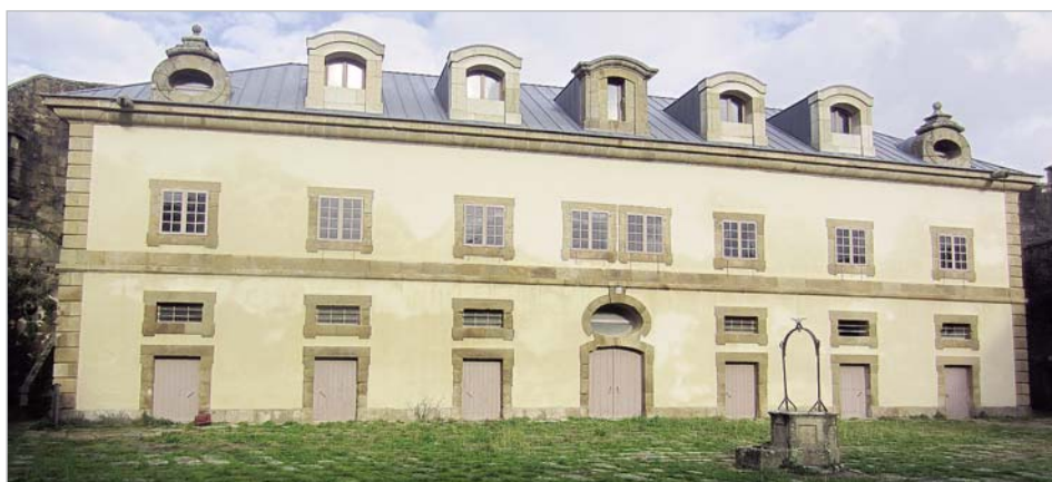
Imaxe das obras coa elevación da nova cuberta de zinc ausencia do relouo
