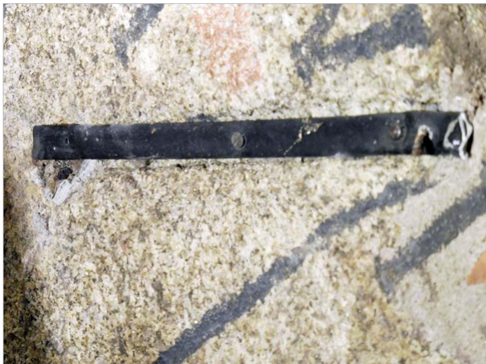
Detalle da varilla do "gnomon". Unha peza de aluminio dunha antena, atornillada
