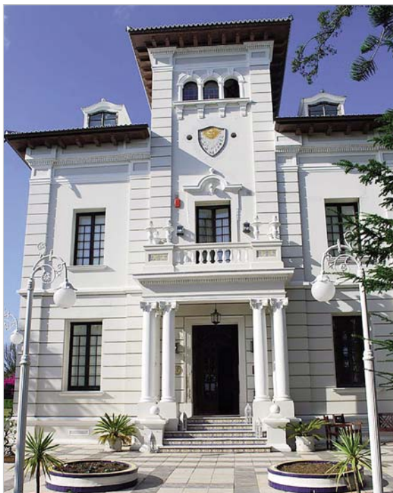
Fachada principal na que se aprecia o reloxo na súa parte superior
