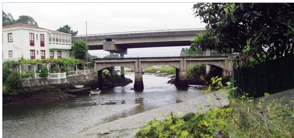
Dúas pontes sobre o Lambre na Ponte do Porco
