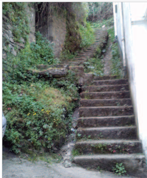
Escaleiras do Monumento
