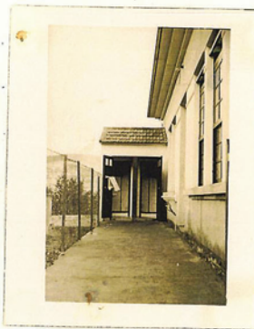
Vista del nuevo servicio de chicos en la parte N.O. del edificio.
