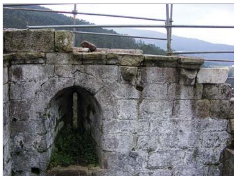
Figs. 61, 62. Traballos de limpeza do coroamento: paramentos suroeste (cornixa interior, ménsulas e seteira ST-0.3) e sueste (cornixa interna)
