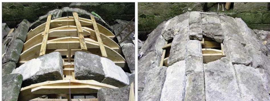
Figs. 76, 77. Proceso de remontado da bóveda do alxibe mediante o emprego de cimbra de madeira
