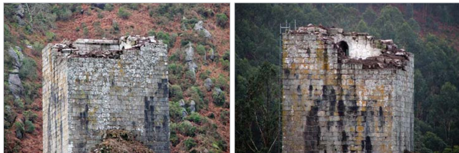
Figs. 59, 60. Coroamento da torre libre de vexetación: vistas norte e nordés
