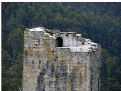
Fig. 65. Coroamento da torre xa impermeabilizado. Vista nordés
