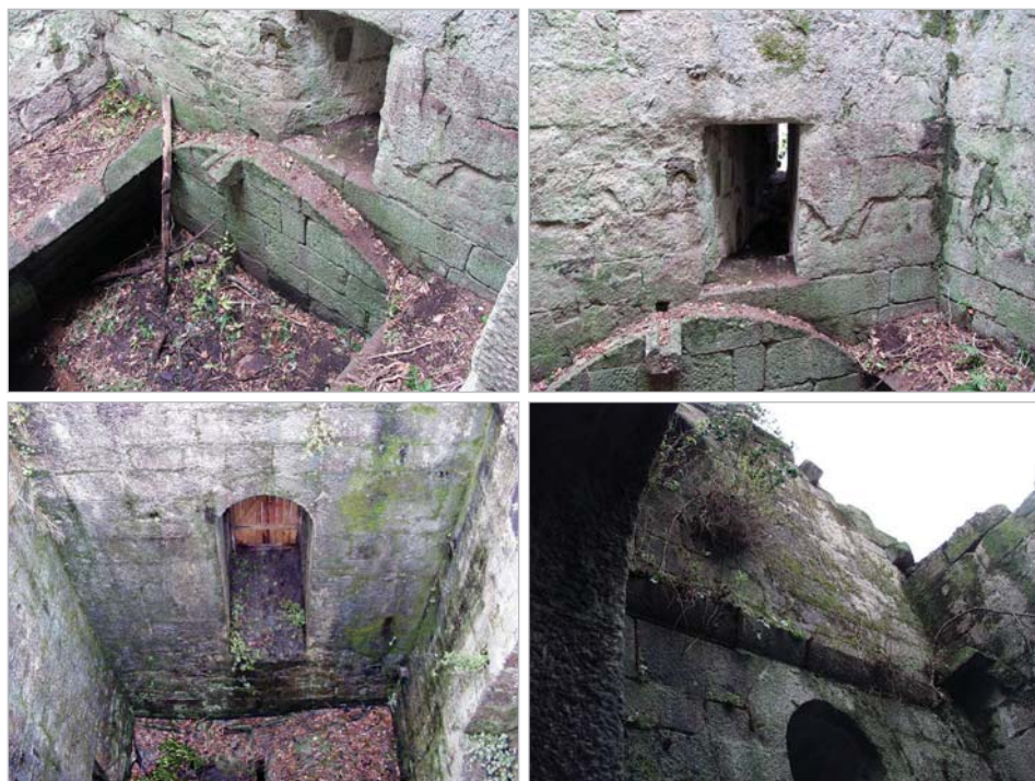
Figs. 55–58. Interior da torre da homenaxe antes da actuación: alxibe, seteira ST-0.1, porta de acceso elevado e cambota (entre repisa e seteiras ST-0.2 e ST-0.3)
