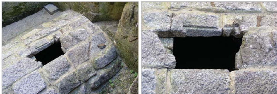
Figs. 78, 79. Anastilose da bóveda do alxibe: vista parcial (área nordés) e detalle da boqueira orixinal
