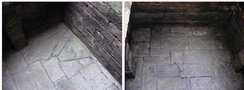
Figs. 71–73. Vista do solado do alxibe: rocha rebaixada no vértice norte (sup. e esqda.) concertando con lousa granítica.
