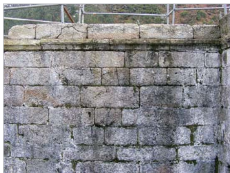
Figs. 61, 62. Traballos de limpeza do coroamento: paramentos suroeste (cornixa interior, ménsulas e seteira ST-0.3) e sueste (cornixa interna)
