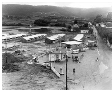
Comezo das obras
