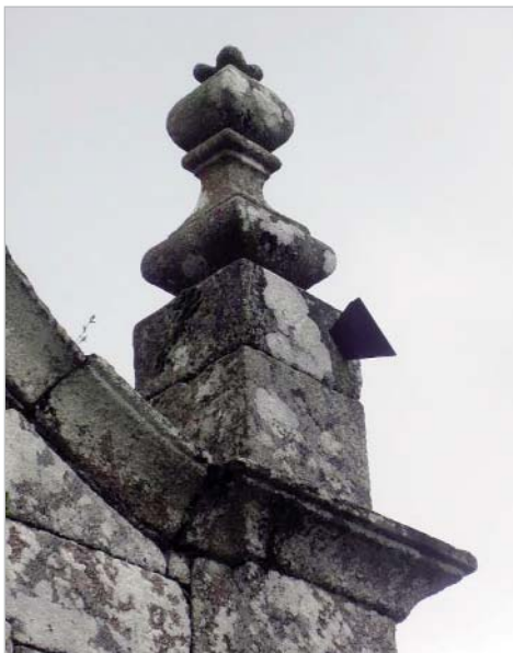
Reloxo triplo (vertical oriental, vertical meridional e vertical occidental) na base dun pináculo da fachada principal
