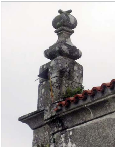
Reloxo triplo (vertical oriental, vertical meridional e vertical occidental) na base dun pináculo da fachada principal
