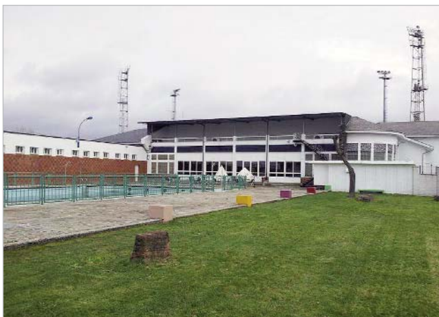
Vista do conjunto
