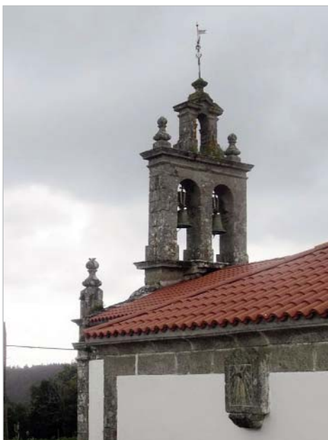
Reloxa vertical meridional na fachada sur
