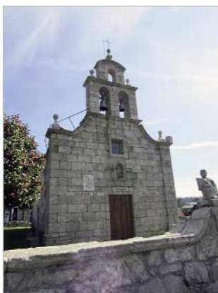
Fachada a poñente da igrexa
