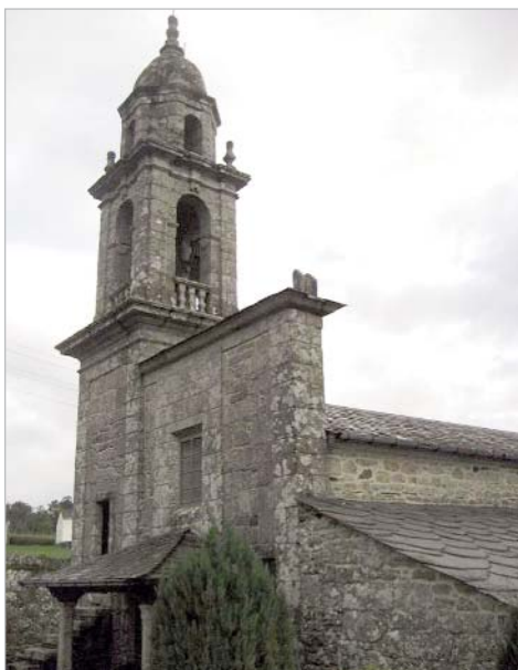
Vista parcial das fachadas sur e oeste
