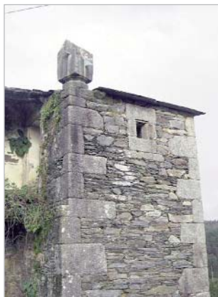
Detalle do reloxo sobre o esquinal
