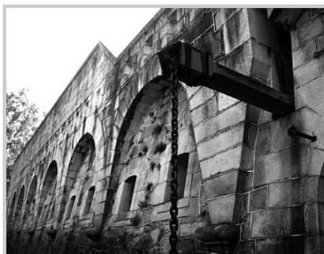
FIG 9: Fachada exterior de la línea de gola
