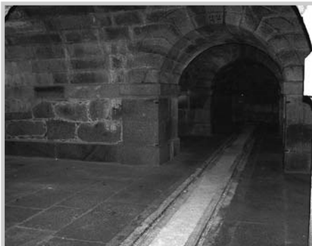
FIG 6: Corredor con sistema de rails
