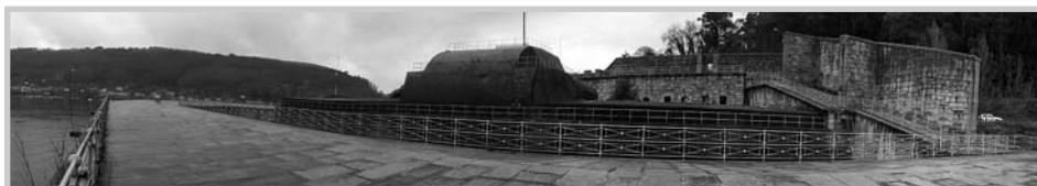
FIG 11: Foto panorámica de la cubierta. Destaca el volumen del través acasamatado que sobresale por encima del nivel de la misma
