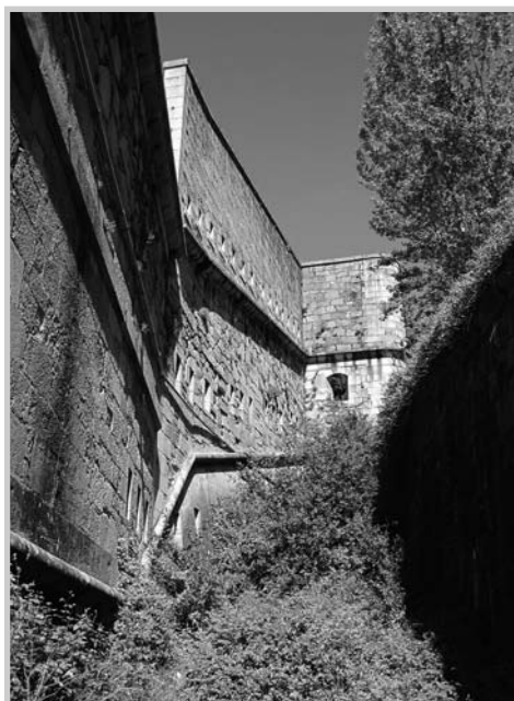
FIG 10: Fachada exterior de la galería aspillera (desde el foso)
