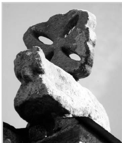
Foto 16 - San Paulo de Riobarba. Carnero sobre el ángulo S de la fachada
