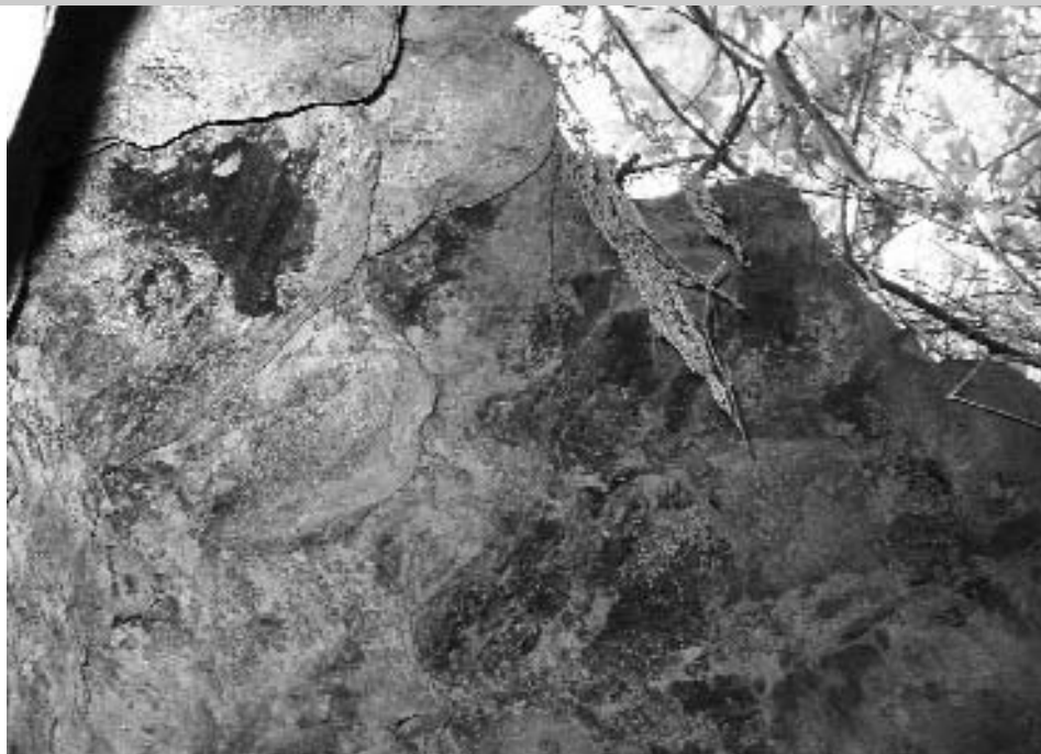
Detalle da cuberta do forno. Obsérvase a teitume conformada a base de fleiras de lousa
