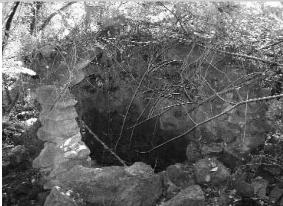
Vista posterior do forno. En primeiro plano a porción do muro derrubado fotografado no verán
