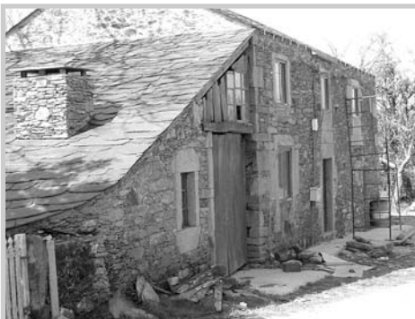
Casa en proceso de rehabilitación en Xestoso, con vistas a ser empregada como aloxamento rural. A recuperación da pedra nesta rexión é máis doada que na mariña, dado que o aspecto do muro soe conservarse intacto ata a actualidade.
