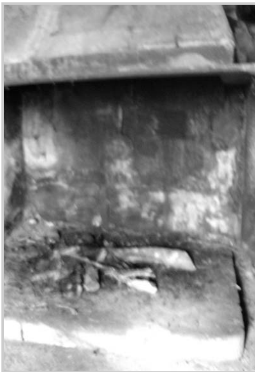
Lareira nunha vivenda habitada ata hai un par de anos. A súa forma é sinxela: unha pedra de gran sobre o chan, a escasa altura, onde se prende o lume, e unha cambota de madeira para que saia o fume. A súa estrutura é característica de comezos do século XX.
