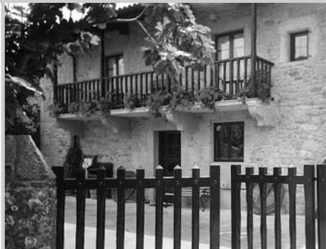
Casa recentemente rehabilitada para turismo rural. Torres (Vilarmaior). O granito á vista dálle o seu aspecto característico.
