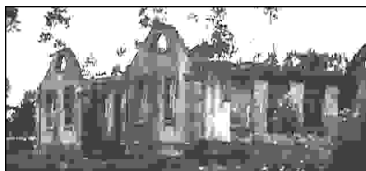
Ruínas do edificio escolar de Moeche.
