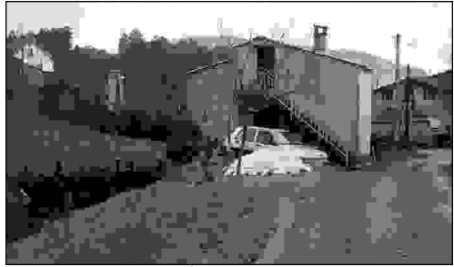
Fachada posterior do edificio.
