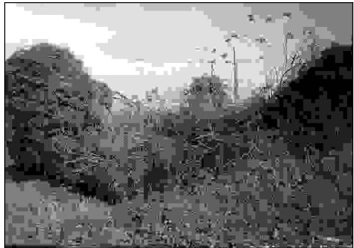
A maleza impide apreciar se quedan restos da fachada principal.
