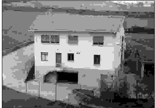
Estado actual do edificio.
