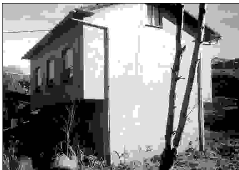
Estado actual do edificio.
