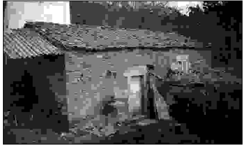
Fachada principal do muíño.
