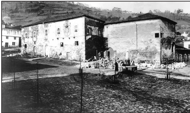
Pazo dos Andrade pouco antes da súa demolición
