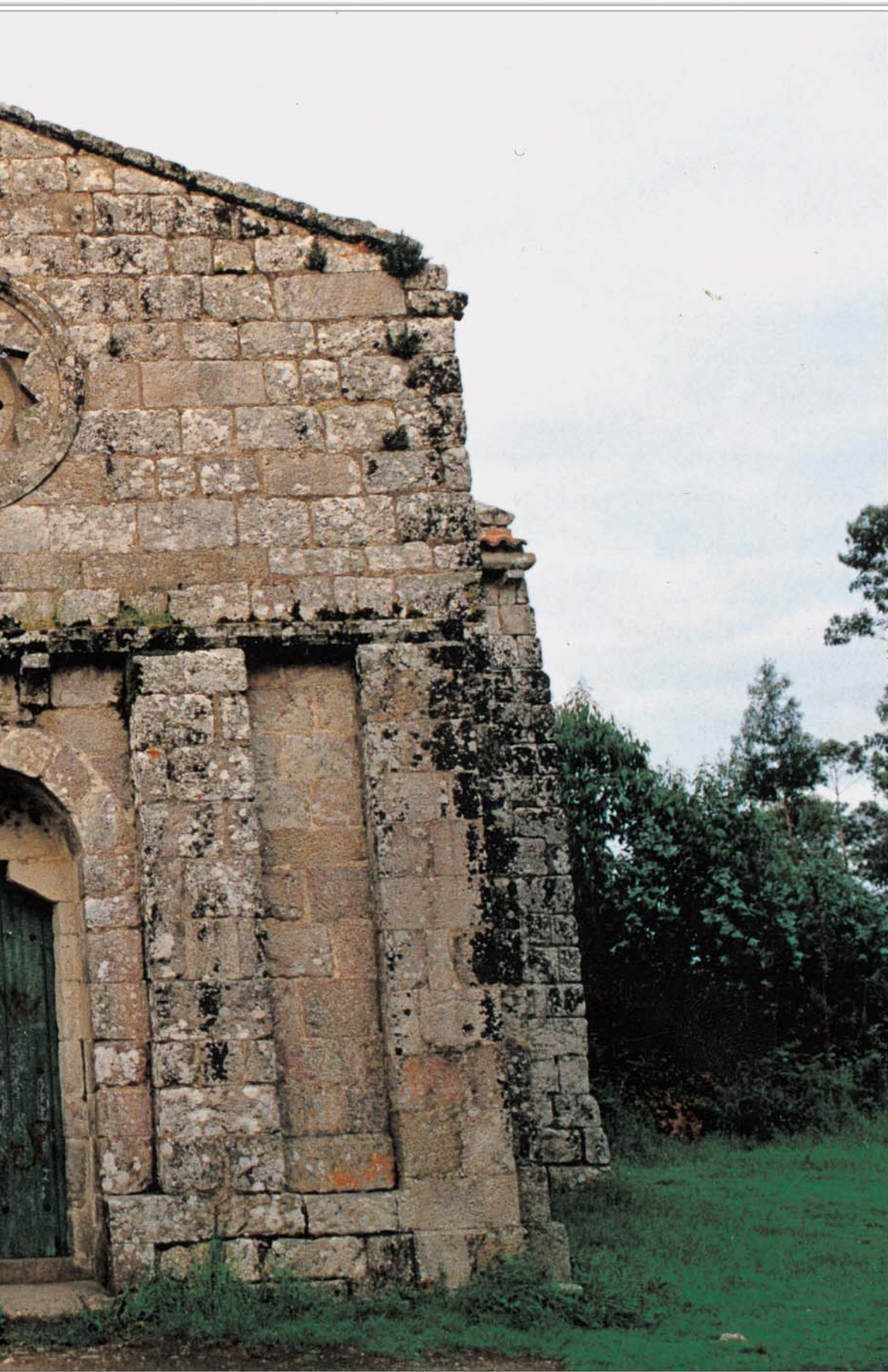
Fachada principal de San Miguel de Breamo.
