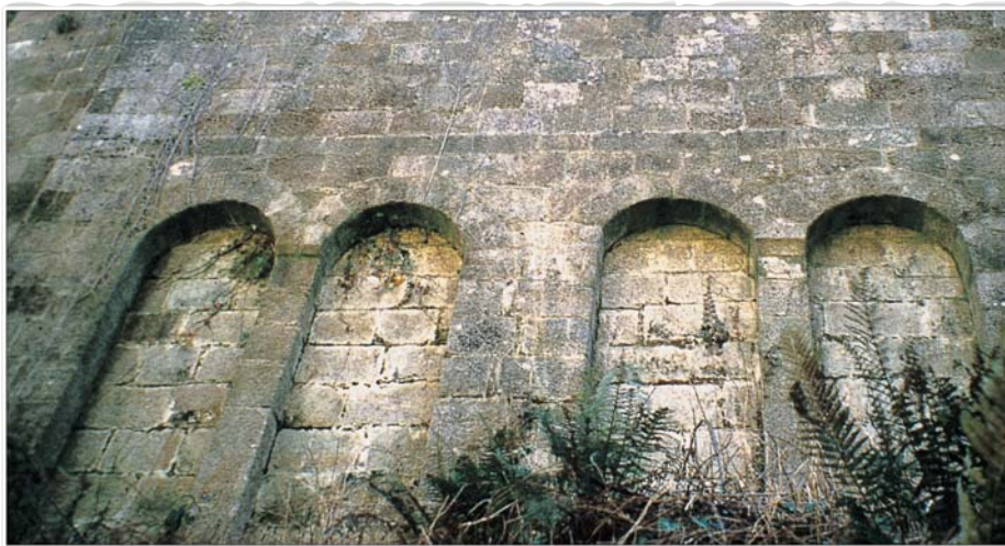
Muro de contención noro- oriental do mosteiro de Caaveiro.
