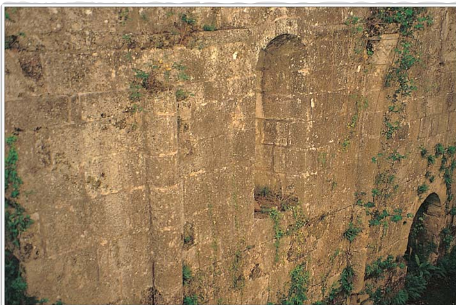
Muro meridional da primitiva igrexa románica.
