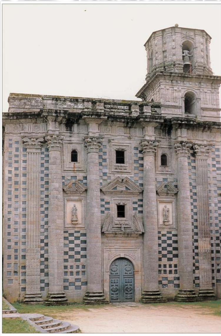
Fachada principal da Igrexa do Mosteiro.
