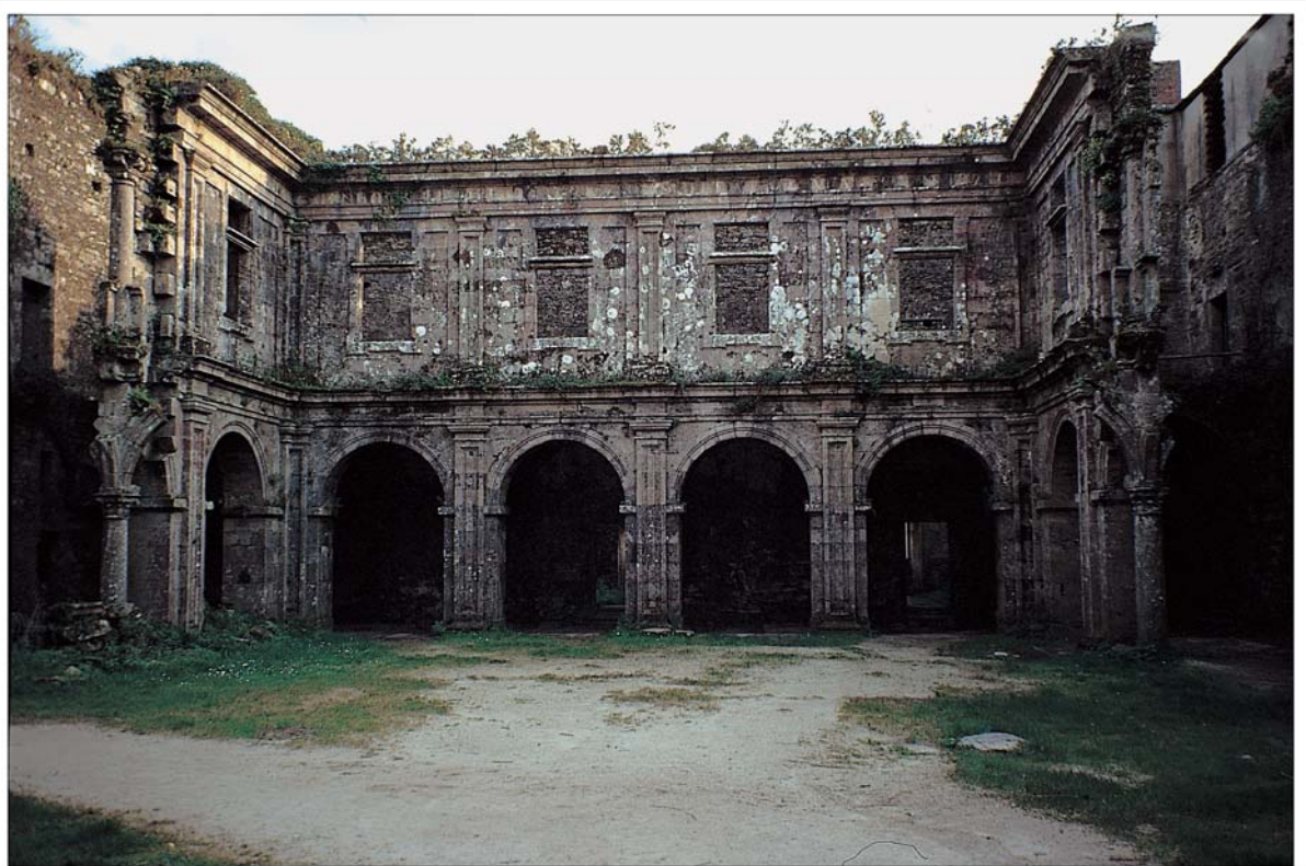
Restos do inconcluso claustro da hospedería.
